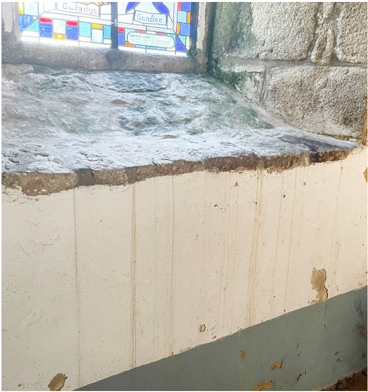
Coulures au droit du vitrail du pignon sud, absence de ventilation et de gorge de récupération des eaux de condensation
