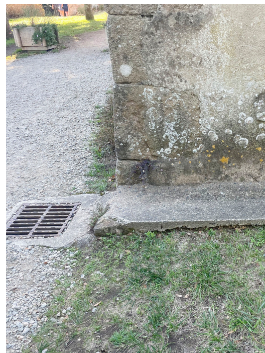
Caniveau béton entraînant un rejaillissement en pied de façade
