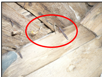
Présence d'un peu de pourriture fibreuse localisée sur des voliges au creux d'une noue.
