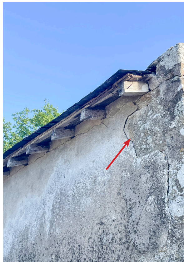
Fissure de l'enduit en façade nord de la sacristie
