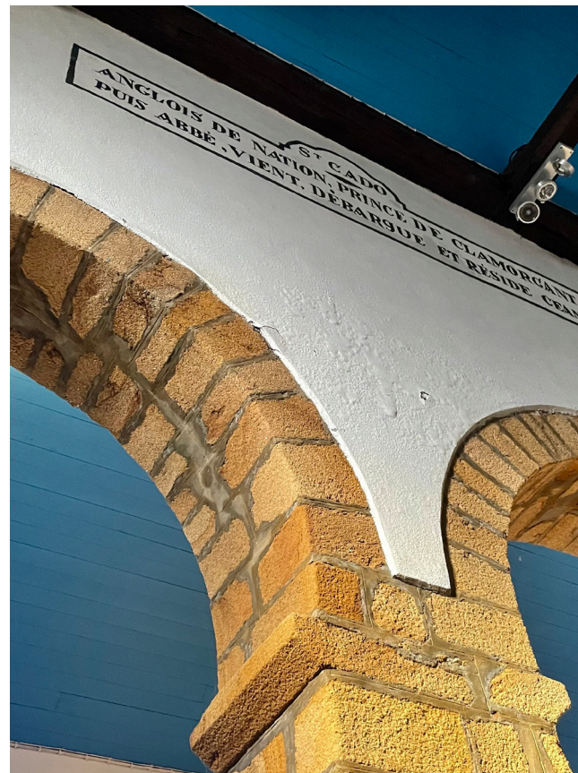
Piliers et arcs en pierre de taille jointoyés au ciment gris avec enduit en surépaisseur
