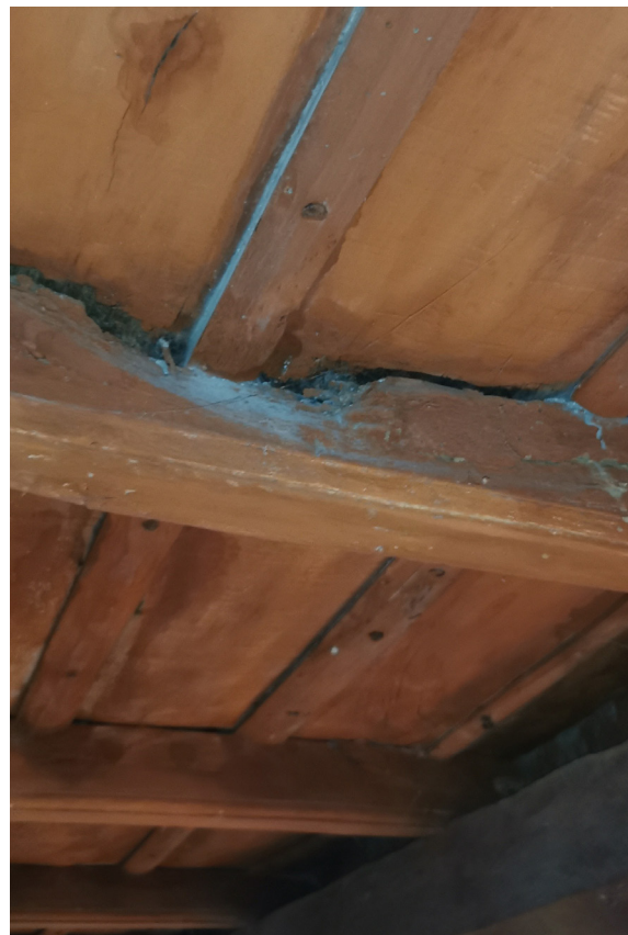
Solive attaquée avec forte perte de section
