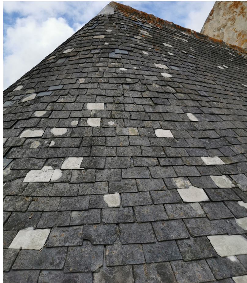
Ardoises posées au clou fortement dégradées : ardoises cassées, glissées, manquantes
