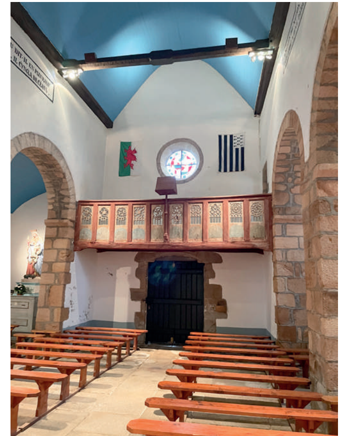
Vue sur la tribune depuis la nef, voûte lambrissée et entrails visibles
