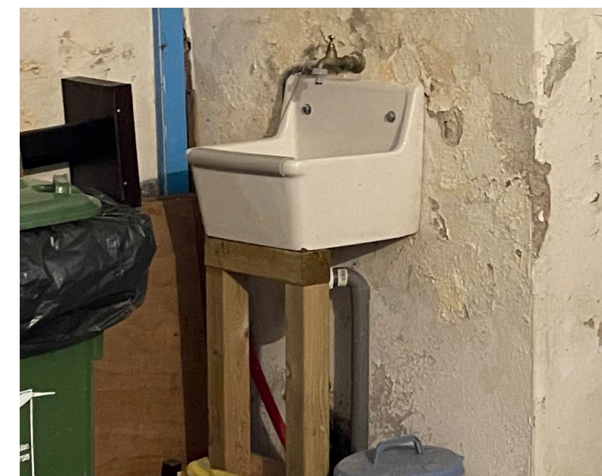
Lave-mains raccordé sur les eaux pluviales
