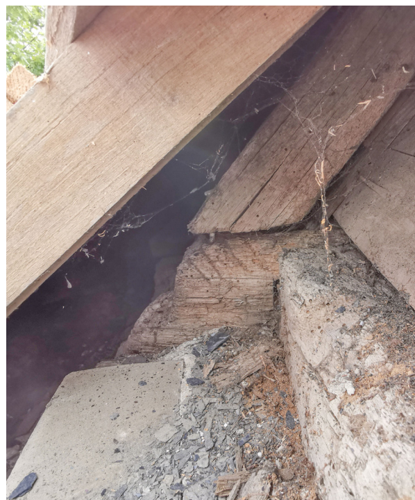
Corniche assemblée avec l'extrémité de l'entrail, traces d'attaques parasitaires
