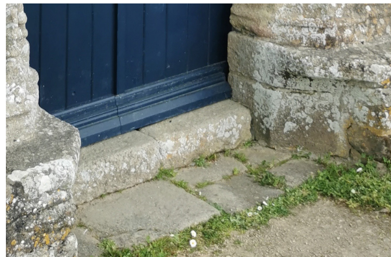
Seuil en granit du portail ouest ajouté et formant un obstacle à l'accessibilité
