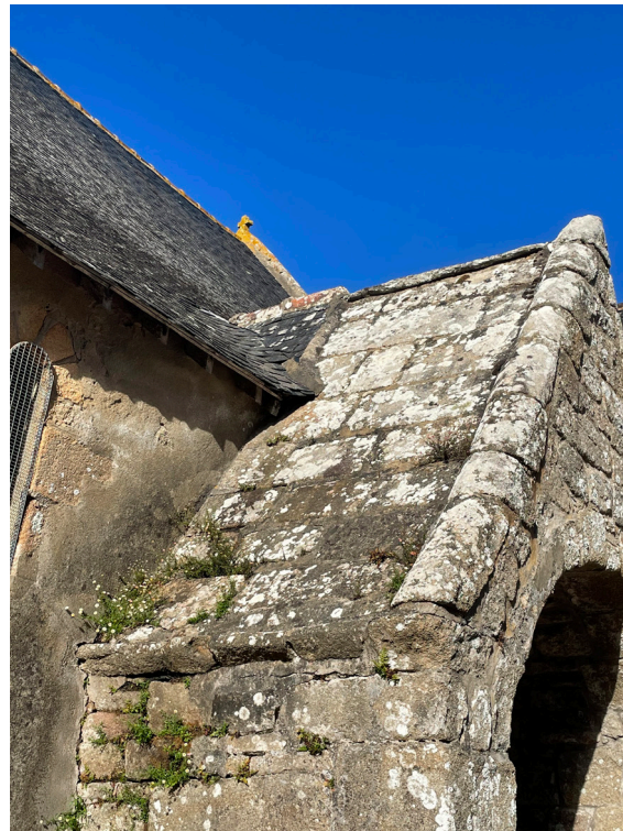
Couverture du porche en dalles de granit dont les joints sont évidés
