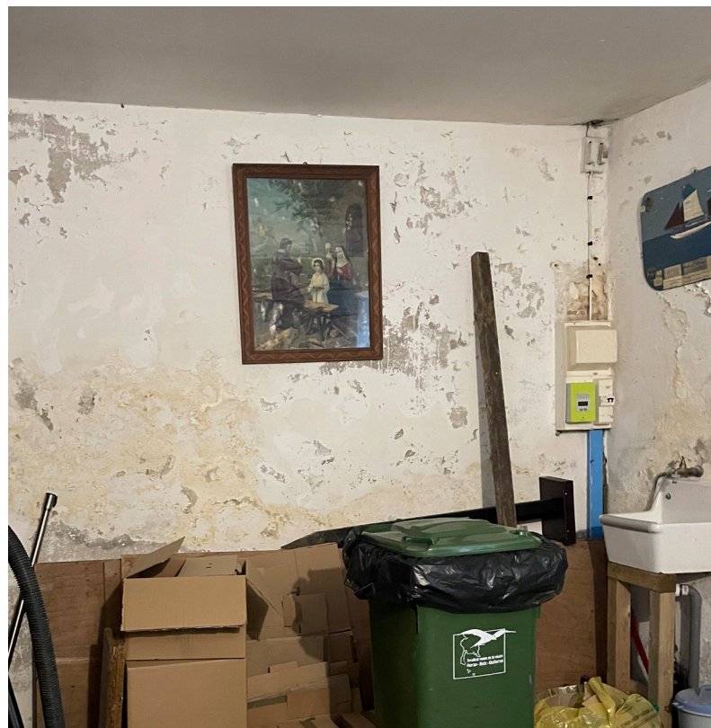
Nombreuses efflorescences sur les enduits intérieurs (ici la sacristie)
