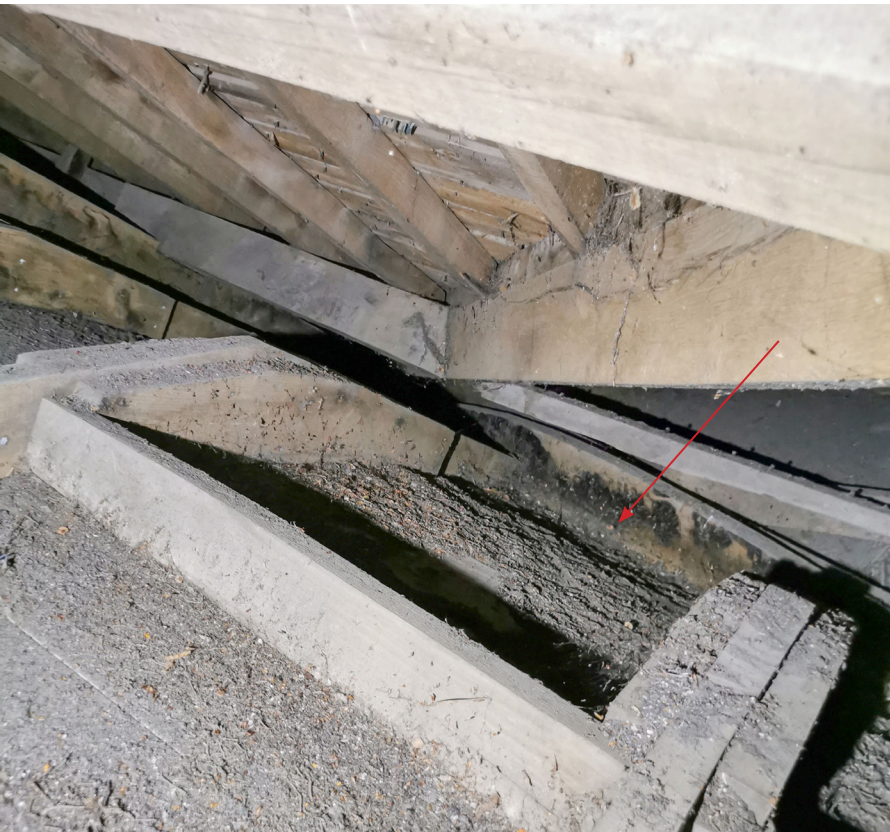
Traces d'humidité en pied de noue
