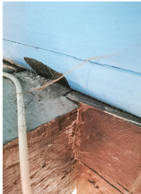
Assemblage des corniches avec les entrails à mi-bois dans les deux sens
