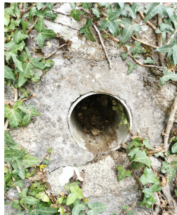
Evacuation des eaux pluviales dans le muret de soutènement côté fontaine : tuyau bouché
