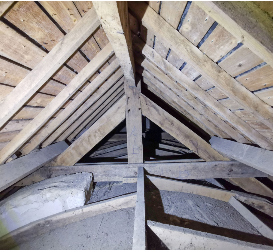
Charpente de la chapelle sud avec entrants moisés sur les arbalétriers et le poinçon
