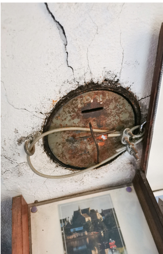
Enduit fissuré autour du tronc oxydé encastré
