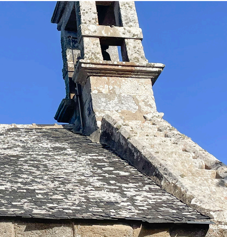
Solins fissurés, passe-corde pour la cloche favorisant les entrées d'eau, absence de gouttière
