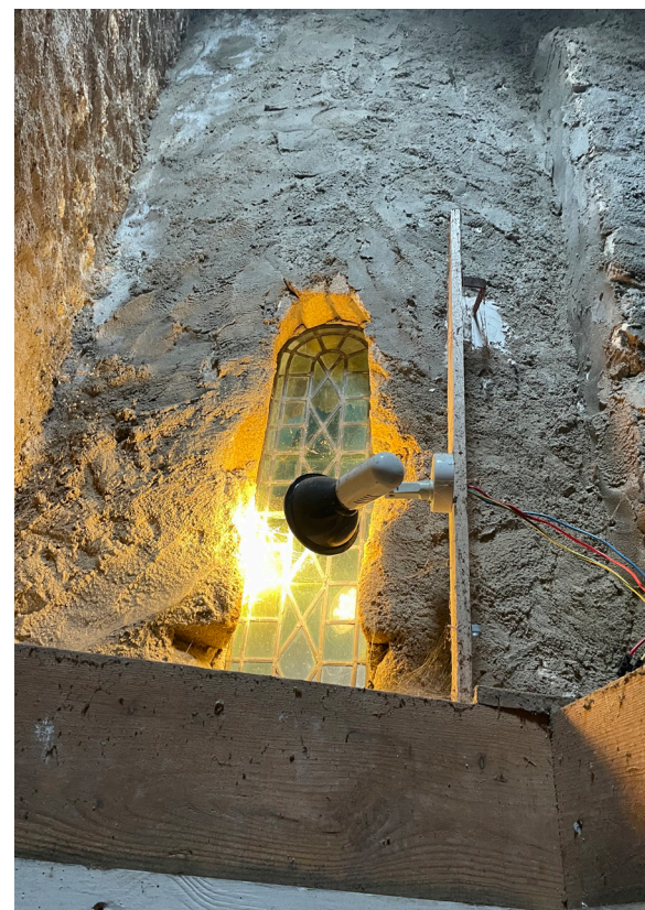
Eclairage en combles - fils apparents
