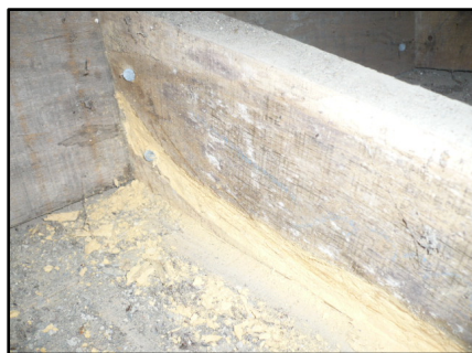
Traces d'attaques de type Lytus, avec activité, sur des parties aubieuses de charpente.
