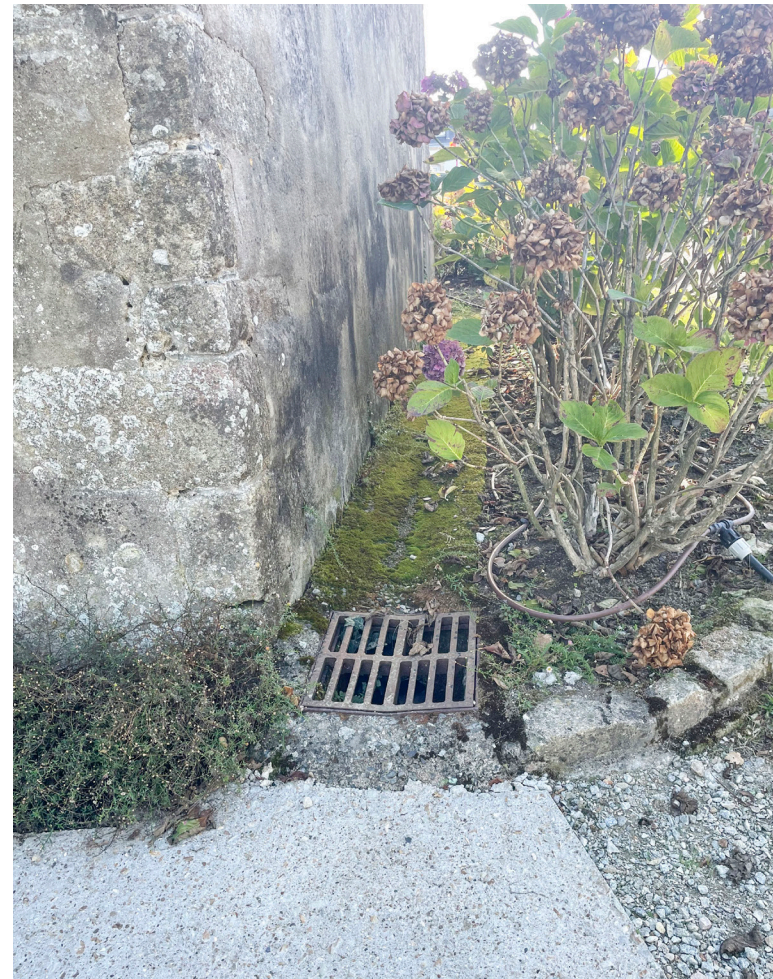
Avaloir en extrémité d'un caniveau nord envahi de mousse et système d'arrosage par goutte à goutte
