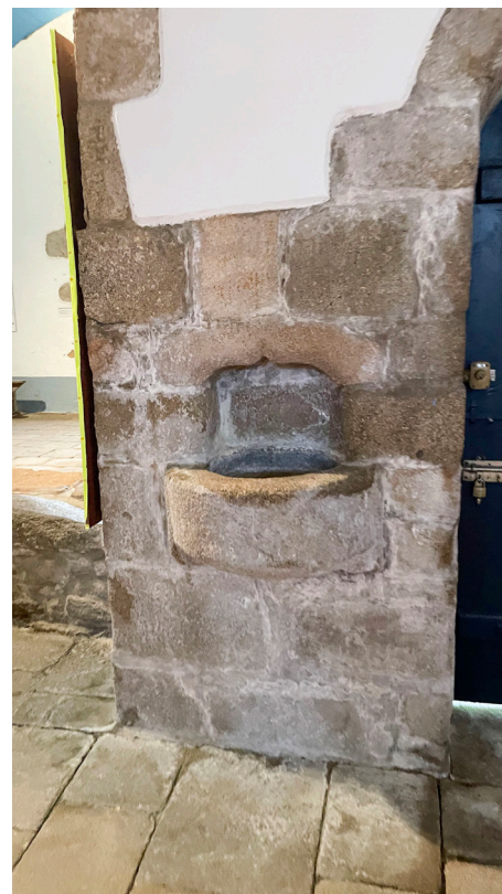
Traces d'humidité dans les maçonneries au droit du porche
