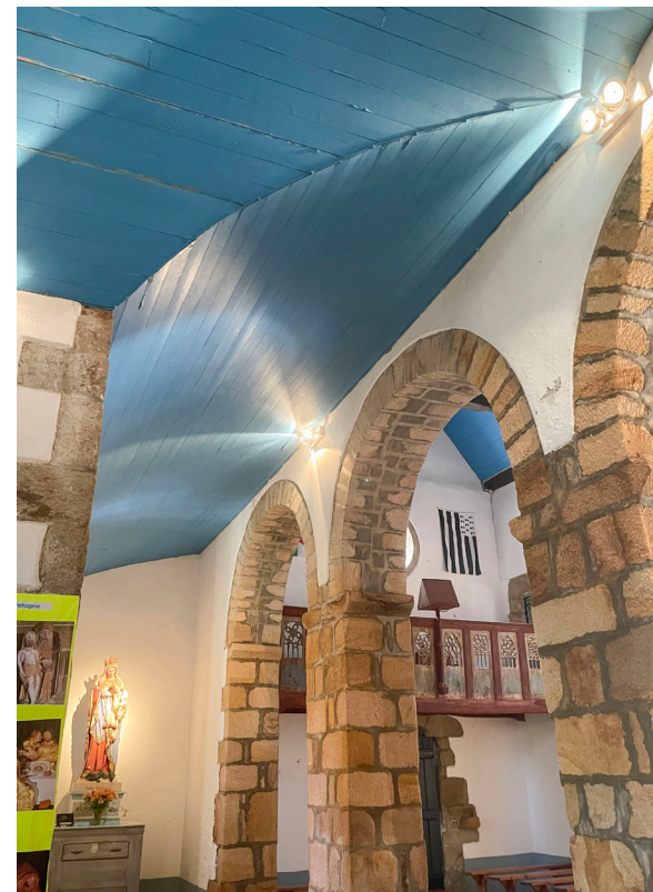
Voûte lambrissée du bas-côté sud au niveau de la jonction avec la chapelle sud
