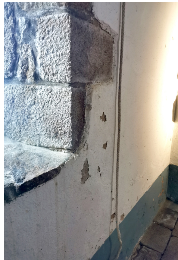
Enduit en surépaisseur, peinture qui se décolle coulures sous les baies et joints ciment
