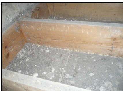
Traces d'attaques de Petite Vrille avec activité sur les solives des combles de la sacristie.
