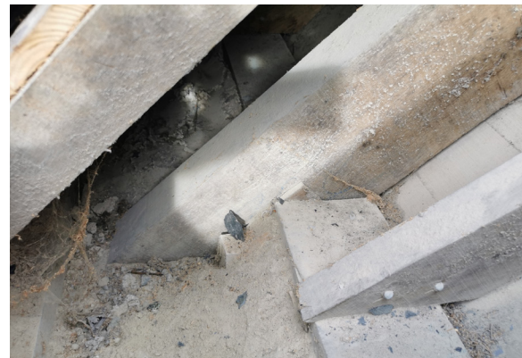
Pied d'arbalétrier du bas côté et sablières posés sur les arases, en bon état
