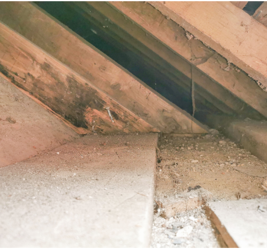
Pied de charpente avec traces d'humidité
