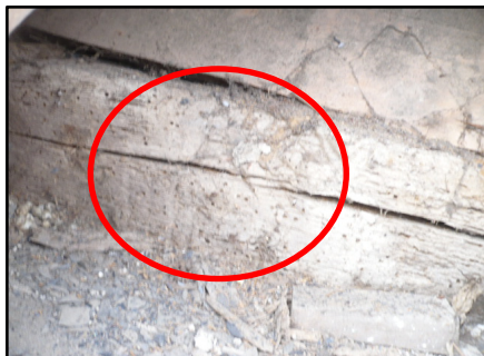
Traces d'attaques de Grosse Vrille sur la panne sablière (sondage S3).
