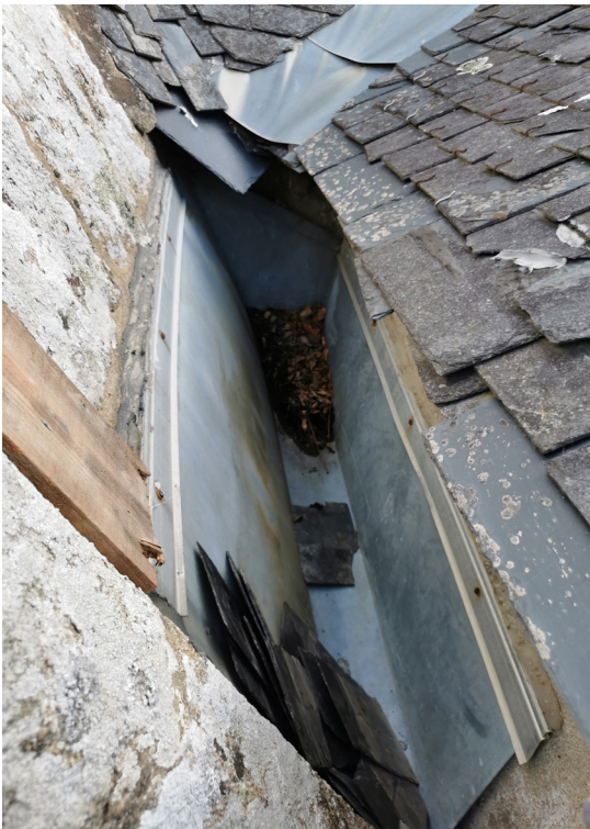
Chéneau en zinc calfeutré au silicone entre chapelle sud et porche
