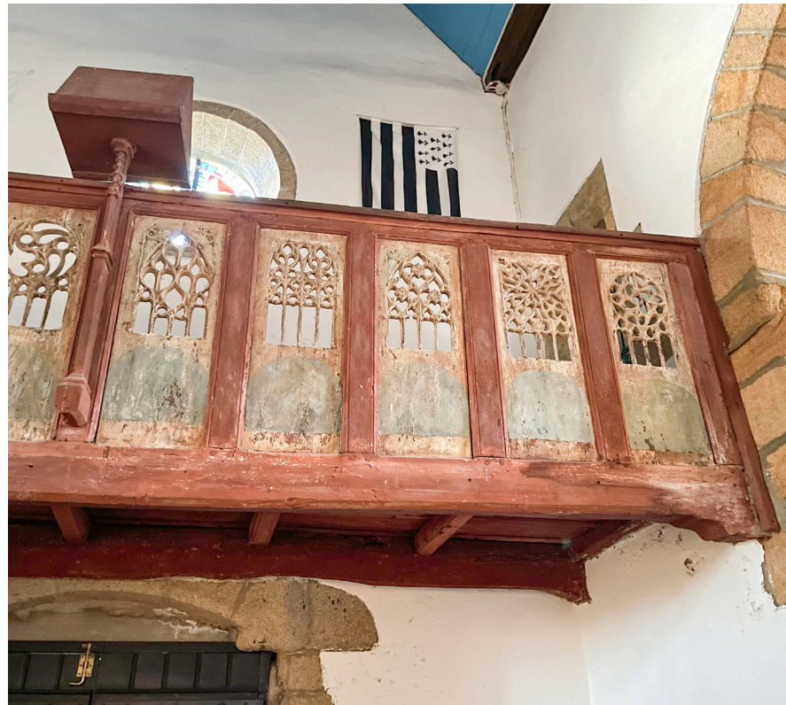
Trace d'humidité à l'extrémité de la poutre support de la tribune et garde-corps ajouré à restaurer
