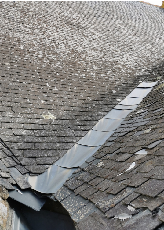
La noue de la chapelle sud a été réparée en zinc et reste fuyarde
