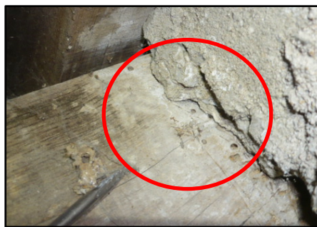
Traces d'attaques de Grosse Vrille sur les abouts de plusieurs pannes de la charpente de la sacristie.
