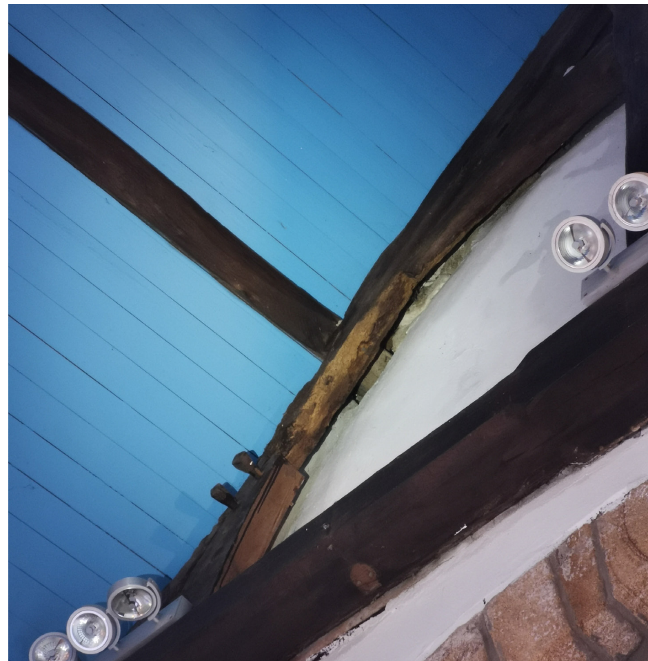
Ferme le long de l'arc entre chœur et nef : attaque parasitaire
