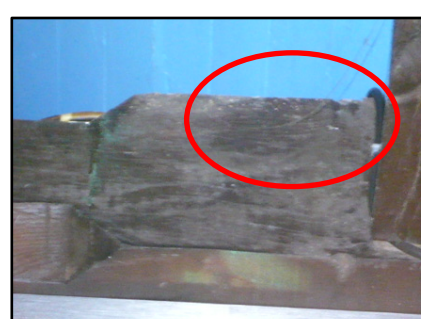
Traces d'attaques de type Lytus, sur un élément de charpente situé au-dessus de la tribune
