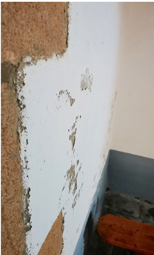
Efflorescences sur les enduits intérieurs
