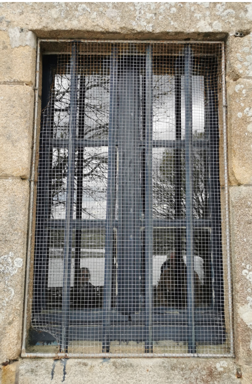
Menuiserie de la sacristie avec barreaux et protection grillagée. Peinture abîmée et mastic à refaire
