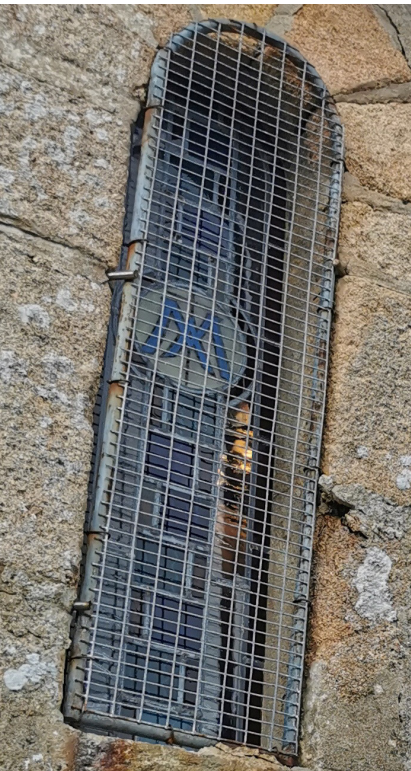
Début d'oxydation de la protection grillagée
