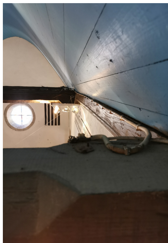
Cheminements des câbles au niveau des entrails et corniches
