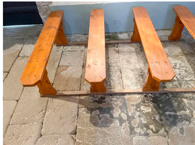
Ragréage au ciment sur le dallage granit dans le bas côté sud
