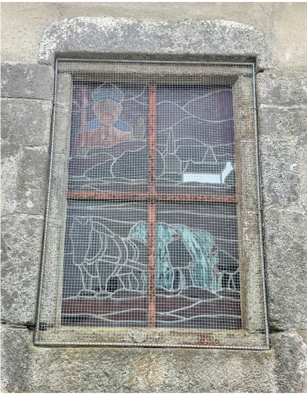
Barlotières oxydées sur les vitraux, début d'oxydation des plombs, protection grillagée en bon état
