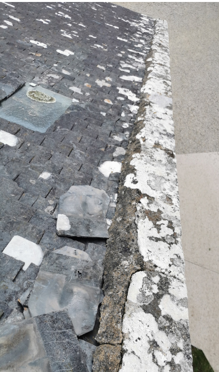
Solins fissurés à l'arrière des chevronnières
