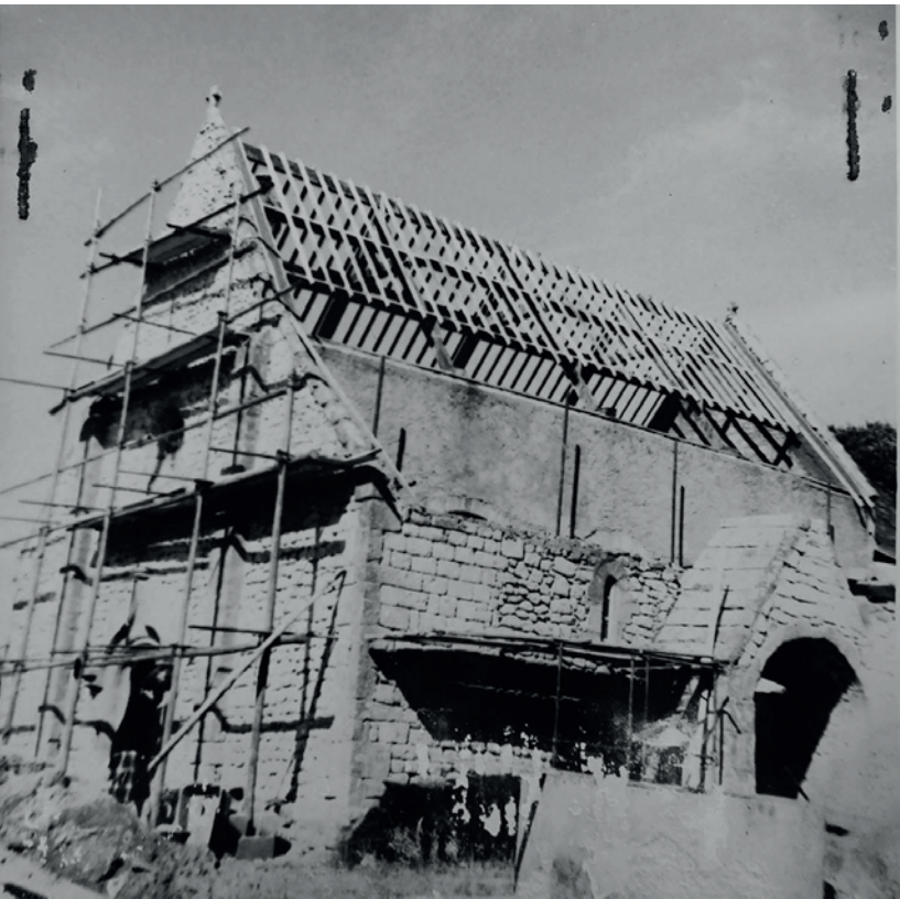
Photo lors de la réfection de la charpente en 1959 - IVR53_20065604760NUCB
