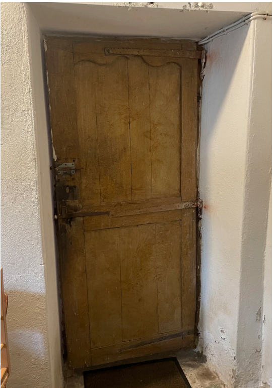
Porte entre la sacristie et le chœur à restaurer (traces de peinture, ferrures oxydées)
