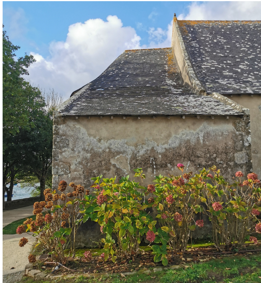
Remontées d'humidité dans les murs avec efflorescences sur les murs
