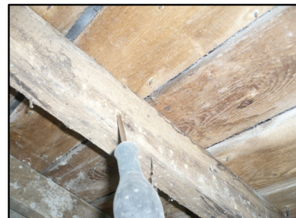
Traces d'attaques de Petite Vrille avec activité sur les pannes de la charpente de la sacristie.
