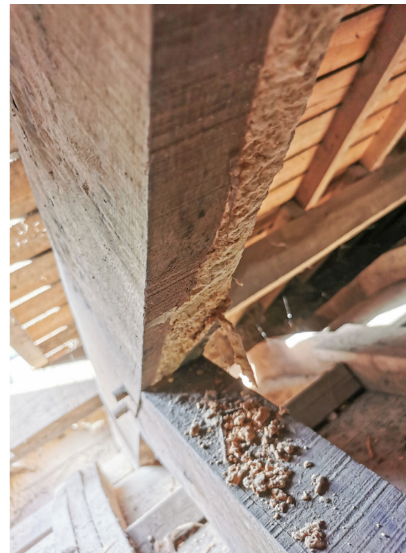
Attaque de lyctus sur la partie aubieuse des arbalétriers du bas-côté sud
