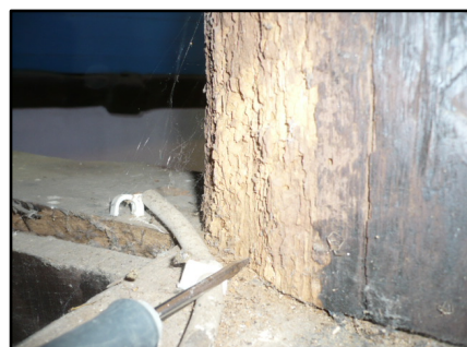
Traces d'attaques de Grosse Vrille sur les éléments de charpente de la partie hôtel.
