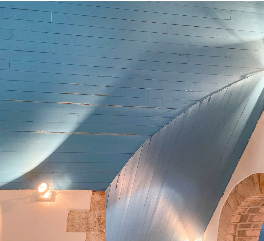
Voûte lambrissée dans la chapelle sud avec traces d'infiltrations
