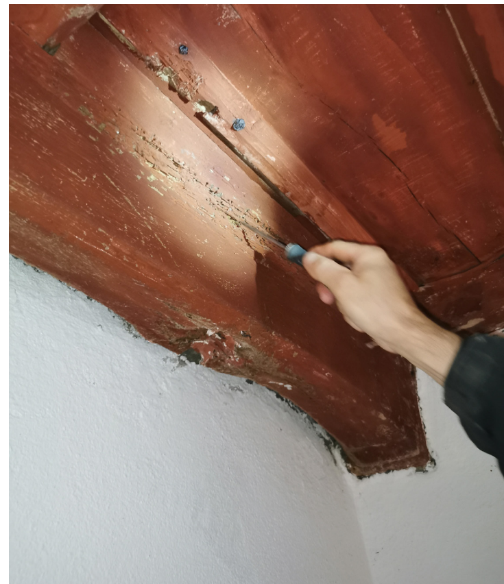
Solivage attaqué et bois ayant perdu sa résistance mécanique, empochements altérés
