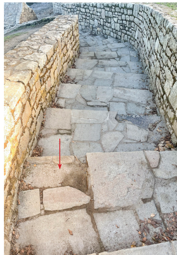
Dallage manquant dans l'escalier de la fontaine
