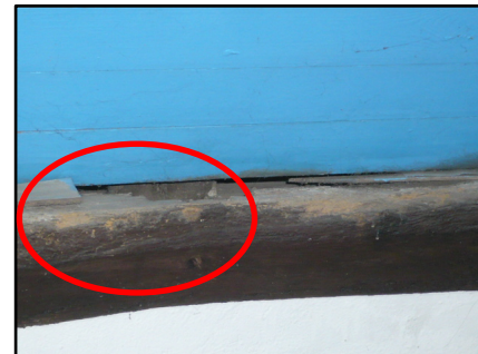
Traces d'attaques de Grosse Vrille sur les pannes sablières situées au-dessus de l'hôtel (avec petites pièces de calages)
